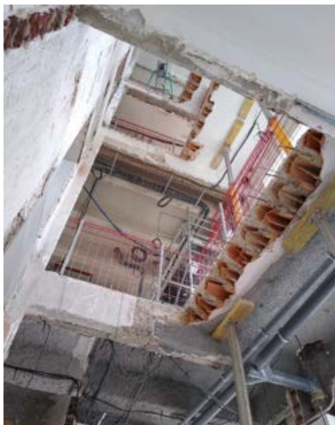
Vue en contre-plongée du percement des étages pour créer la gaine d'ascenseur en août 2023
